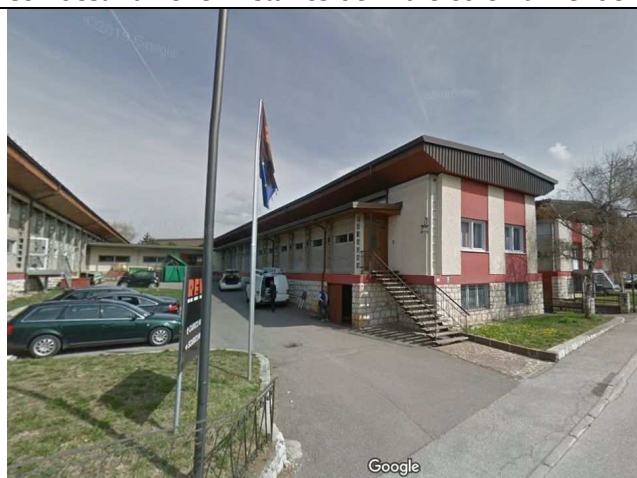
Via de Zinis - Vista del fabbricato produttivo
