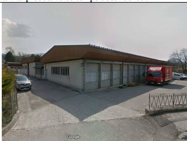
Via de Zinis - Vista del fabbricato produttivo
